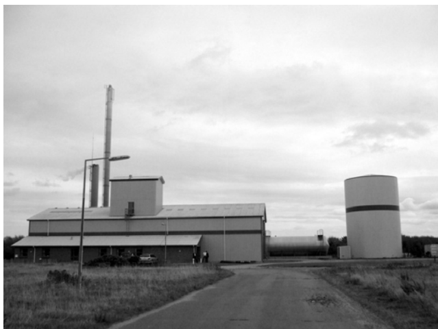
写真1 プラント全景
